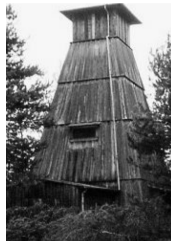
Der Förderer des 1943 aufgewältigten Schachtes.
