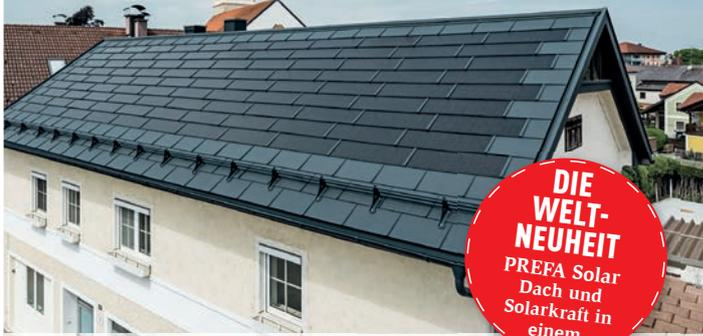
**MIT DEM INNOVATIVEN SOLARDACH BIETET PREFA EINE NOCH NIE DAGEWESENE PRODUKTNEUHEIT FÜR DAS DACH DER ZUKUNFT. ES HANDELT SICH UM EINE ALUMINIUM-DACHPLATTE IN BEWÄHRTER PREFA QUALITÄT MIT EINEM INTEGRIERTEN PHOTOVOLTAIKMODUL, DAS FEST MIT DER GRUNDPLATTE AUS BESCHICHTETEM ALUMINIUM VERBUNDEN IST. DAS ERGEBNIS IST EIN WIDERSTANDSFÄHIGES SOLARDACH MIT ZUKUNFTSWEISENDER TECHNOLOGIE IN EINER HOMOGENEN, ELEGANTEN OPTIK.**
