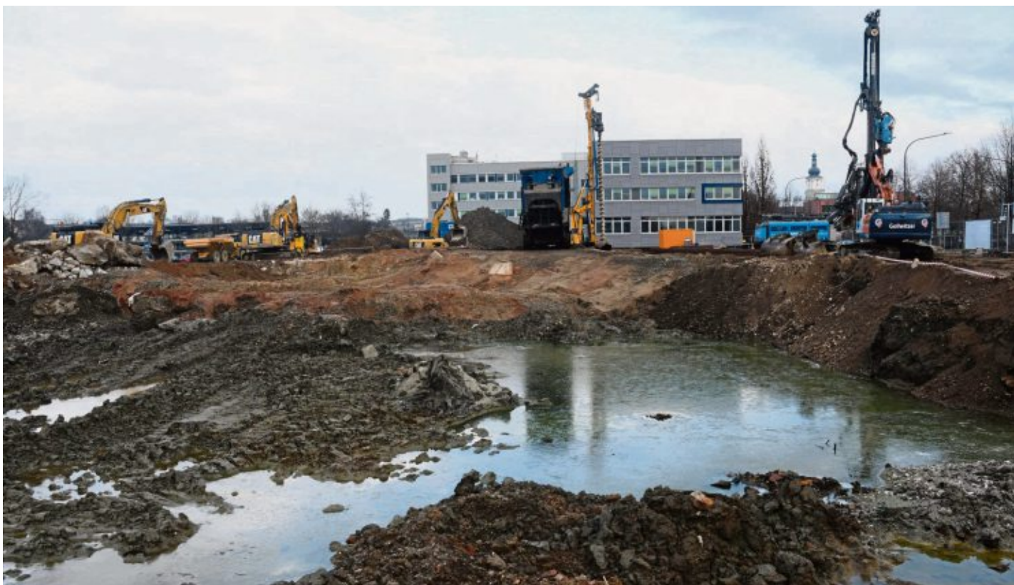
Die Bauarbeiten im ehemaligen Sumpfgelände waren eine Herausforderung.
