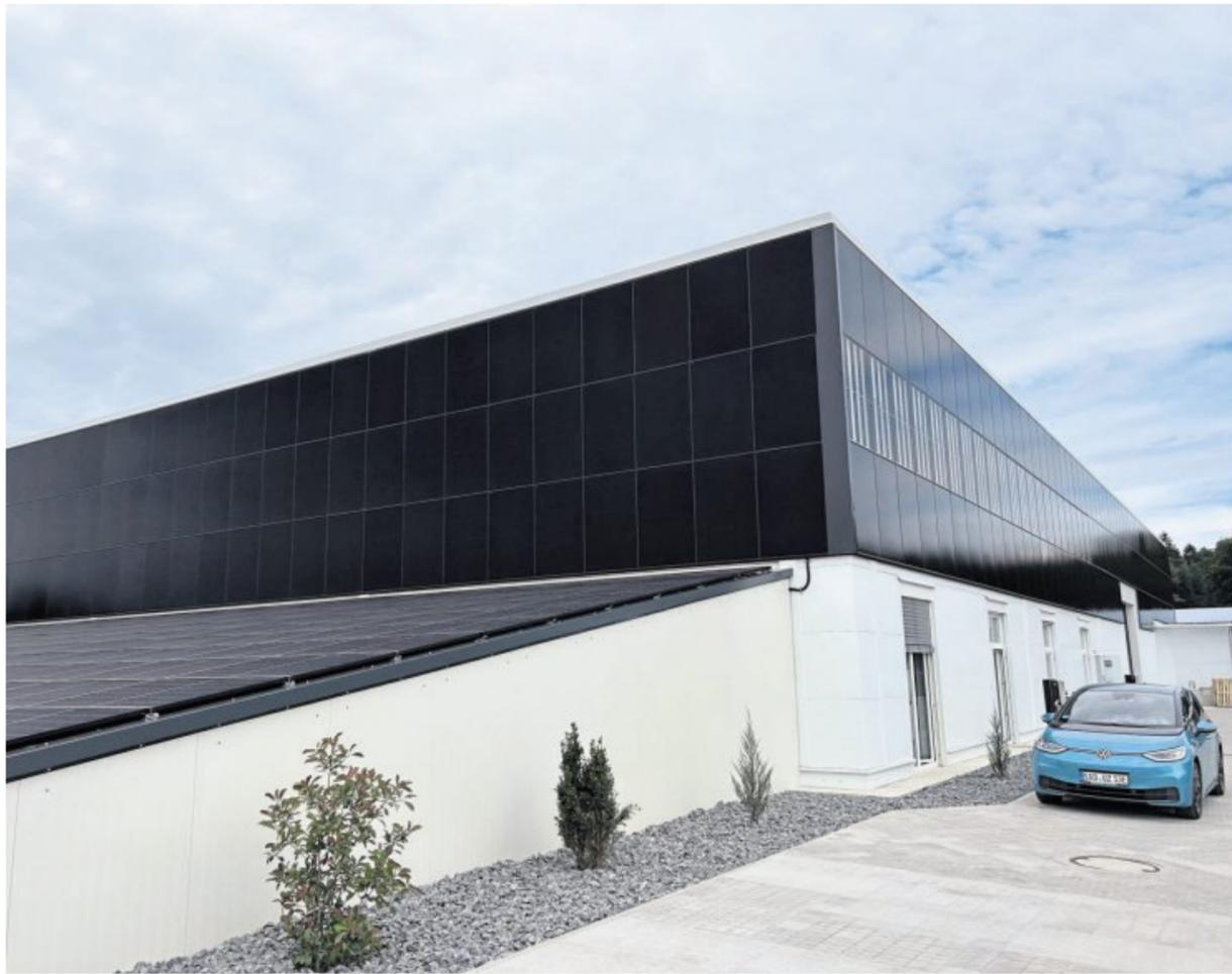
Durch die Photovoltaik-Module auf dem Dach und an den Wänden ist die neue Halle im Zusammenspiel mit weiteren Faktoren wie beispielsweise der Erdwärme-Versorgung an 365 im Jahr komplett energieautark. Bild: exb
