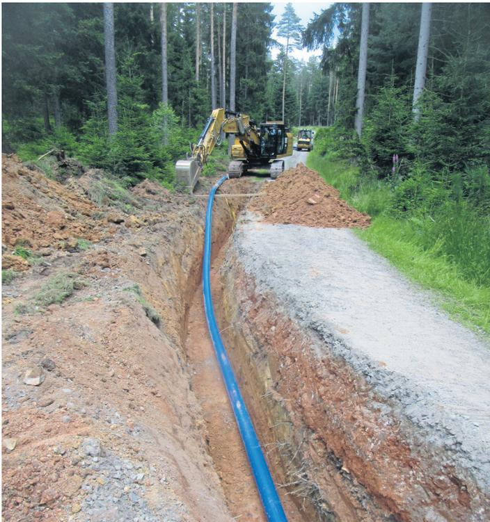
Von April bis September liefen die Bauarbeiten für den Neubau der insgesamt 3750 Meter langen Verbundleitung zwischen Mitterteich und Waldsassen. Insgesamt investiert die Stadt Mitterteich 820000 Euro in die Wasserversicherung für ihre Bürger und Firmen. Bild: jr
