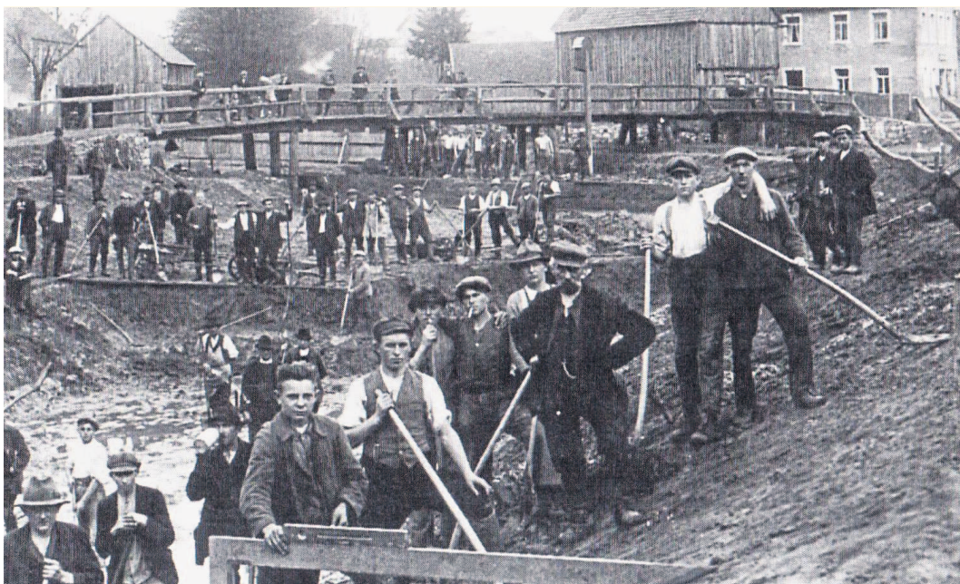
Bei der Vilsregulierung sind viele Männer beschäftigt, auch hier in Schlicht. Der Blick geht flussaufwärts und zeigt die Arbeiter vor dem hölzernen Vilssteg. Rechts das Anwesen Ringer, in dem Zahnarzt Dr. Thomas Ringer später seine Praxis betrieb.
