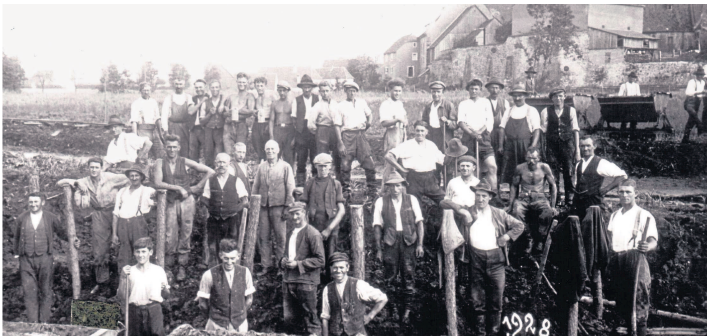
Die Männer haben bei der Vilsregulierung Schwerstarbeit zu leisten, um den Stadtweiher trockenzulegen und die Vils zu begradigen. Im Hintergrund Burg Dagestein.
