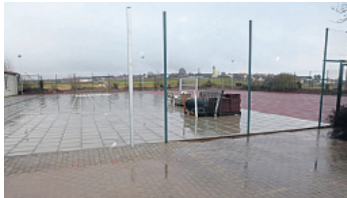
Vor dem Abschluss steht die Sport- und Begegnungsstätte. Zuletzt wurden 700 Beton- und 400 Gummipplatten verlegt. Bild: bk
