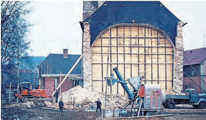
Eine gewaltige Verblendung schließt die Westseite des alten Kirchbaus für die anstehende Erweiterung ab.
