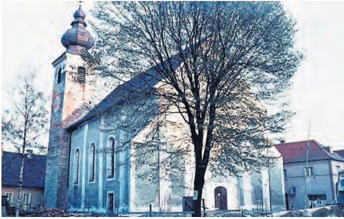
Die Pfarrkirche zu Beginn des Bauprojekts. Der Eingangsbau ist bereits entfernt.
