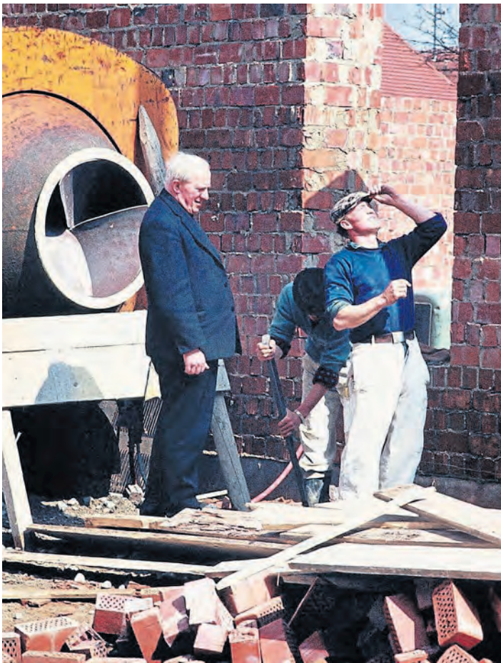
Pfarrer Simon Sindersberger überzeugt sich vom Baufortschritt. Repro: Ig
