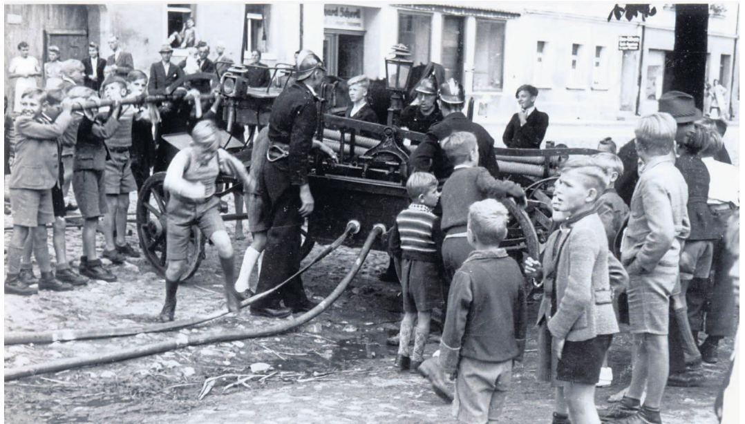
In der Innenstadt demonstrierte die Feuerwehr mit fünf Rohren, dass aus den Hydranten innerhalb kürzester Zeit ausreichend Wasser kommt, um Brände wirkungsvoll zu bekämpfen. Bild: u
