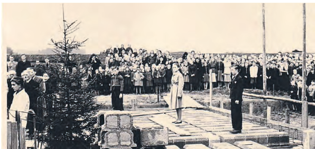
Am 28. Oktober 1954 wurde von Bürgermeister Georg Lederer im Beisein der Schulkinder, Lehrkräfte und einiger Ehrengäste mit einer kleinen Feier der Grundstein für das neue Zentralschulhaus gelegt. Da mit dem Bau im September begonnen wurde, stand schon ein Teil des Erdgeschosses.
