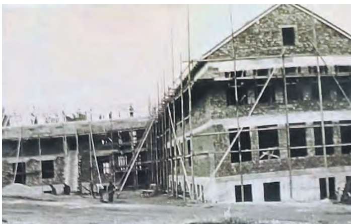
Ende 1955 ist der Rohbau des neuen Schulgebäudes an der Josefstraße schon weit fortgeschritten.
