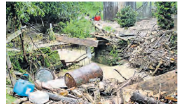
in eine Unwetternacht im Sept. 2006 wurde halb Lessau verwüstet. Bild: op
