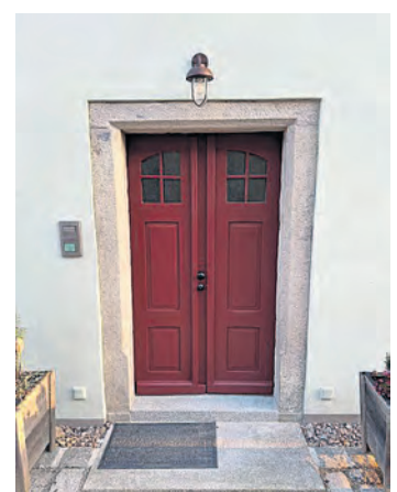
Die originale Haustür wurde ebenfalls instandgesetzt.
