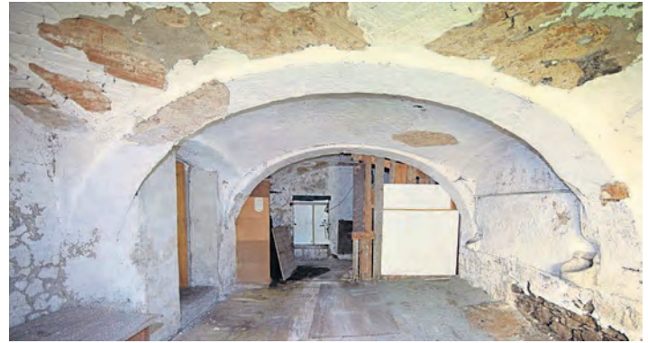
Im Detail wurde großer Wert auf den Erhalt der authentischen Struktur gelegt, so beim Gewölbe des ehemaligen Kuhstalls.
