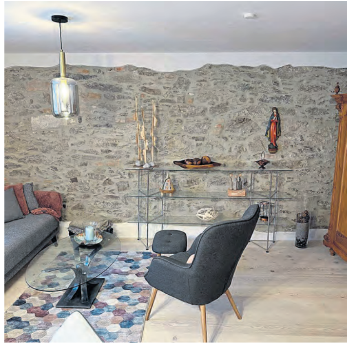
Die freigelegte und dann neu verputzte Bruchsteinmauer in der Ferienwohnung gibt den Blick frei auf frühere Handwerkstechniken.
