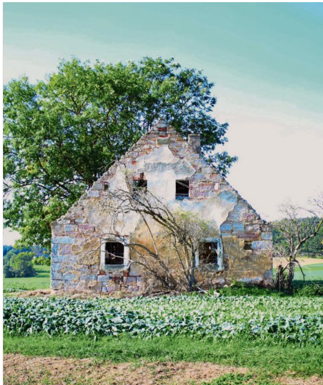
In diesem Haus, das mitten auf einem Feld in der Nähe von Schwandorf steht, wohnt schon lange niemand mehr. Bild: Evi Wagner
