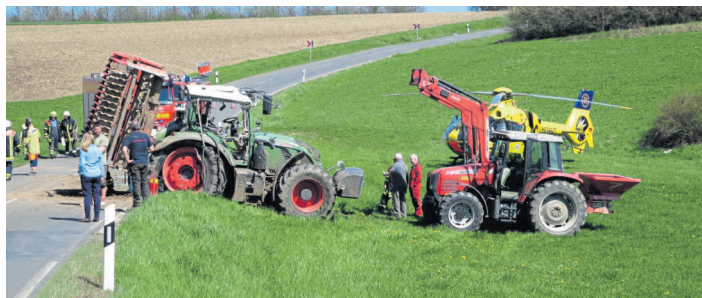
Der Ausbau der Kreisstraße dient unter anderem der Sicherheit. Bild: op
