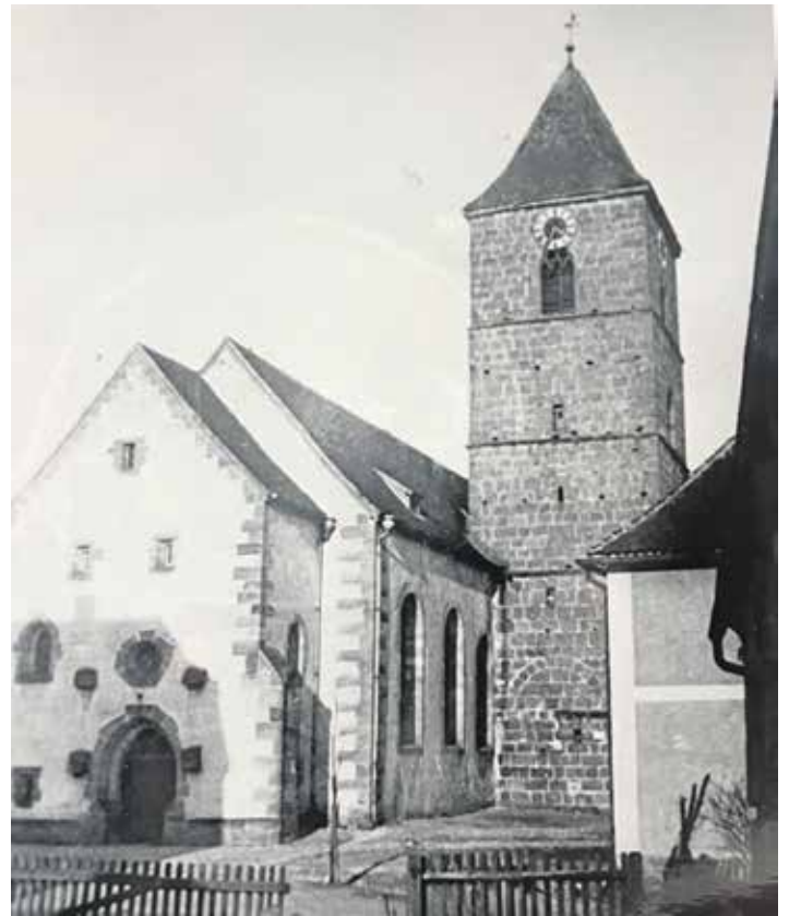
Bereits um 1900 war die ehemalige Wallfahrtskirche Maria Himmelfahrt in Pappenberg denkmalgeschützt. Bei der Absiedelung des Dorfes 1938 wurde Inneneinrichtung der Kirche nach Wolfskofen bei Regensburg gebracht.
