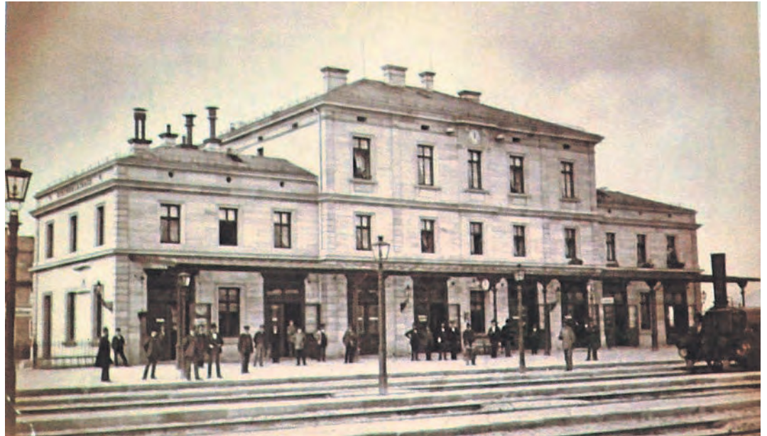
Aus dem Jahr 1880 stammt die älteste bekannte Aufnahme des Empfangsgebäudes. Bild: whü
