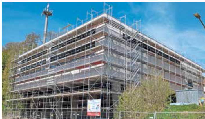
Blick auf die Zweifachturnhalle der Mittelschule. Nach Fertigstellung der Außenanlagen soll das Gebäude voraussichtlich zu Beginn des neuen Schuljahres eingeweiht werden. © Stadt Tirschenreuth, Mirko Streich
