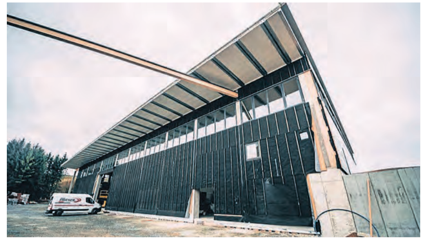
Holzbau Schraml entwickelt sich positiv weiter, vor Kurzem wurde auf dem Betriebsgelände diese neue Halle fertiggestellt. Bilder: Lukas Meister (2)
